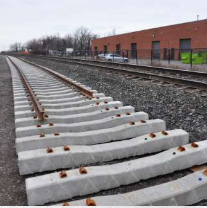
Precast Train rail units قطع كونكريتية لسكة القطار
