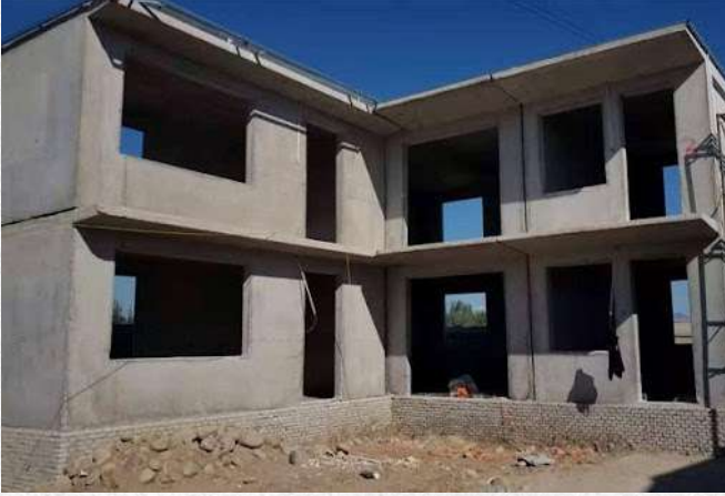
Precast Concrete Residential Complexes مجمعات سكنية
