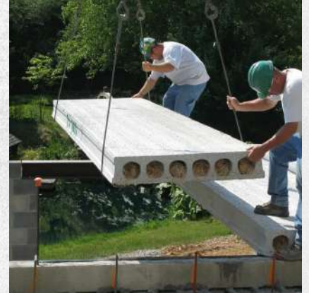
Hollowcore slab - سقف هولوكور
